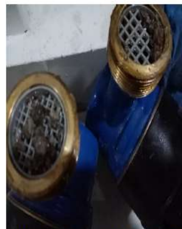
IMPUREZAS ENCONTRADAS EN EL FILTRO DEL MEDIDOR
